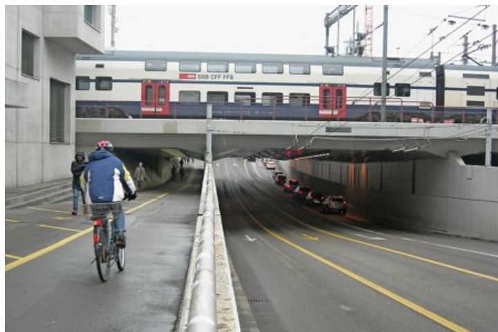
Die Velospur der Langstrassenunterführung könnte 2019 auf die Strasse verlegt werden.
